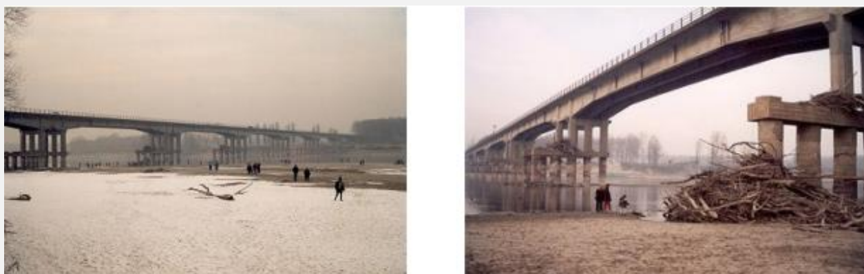
Figura C.11 - Ponti con significativo abbassamento generalizzato dell'alveo.
